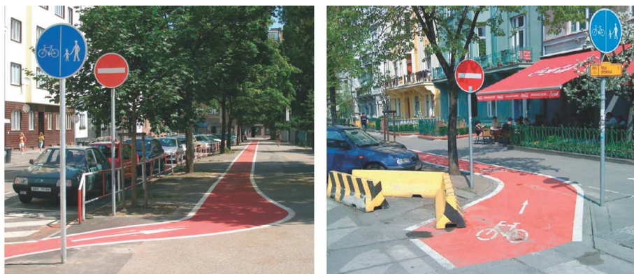
Ukázka protisměrného vjezdu do cykloobousměrky provedené pomocí oddělené stezky mimo vozovku (Praha, Ortenovo náměstí a Ovinecká; pozn.: chybně vysunutý cityblok, chybějící hmatný pás)
