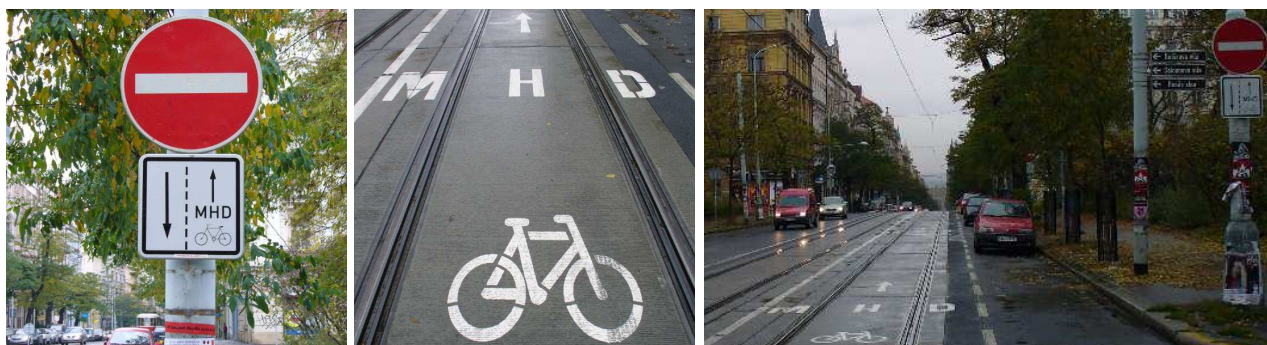
Prostřední pruh pro jízdní kola a vozidla veřejné dopravy – tramvaje a autobusy (Praha, Korunní)
